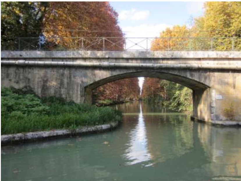
CANAL DE GARONNE : Pont de « Burenque » à BUZET SUR BAISE
